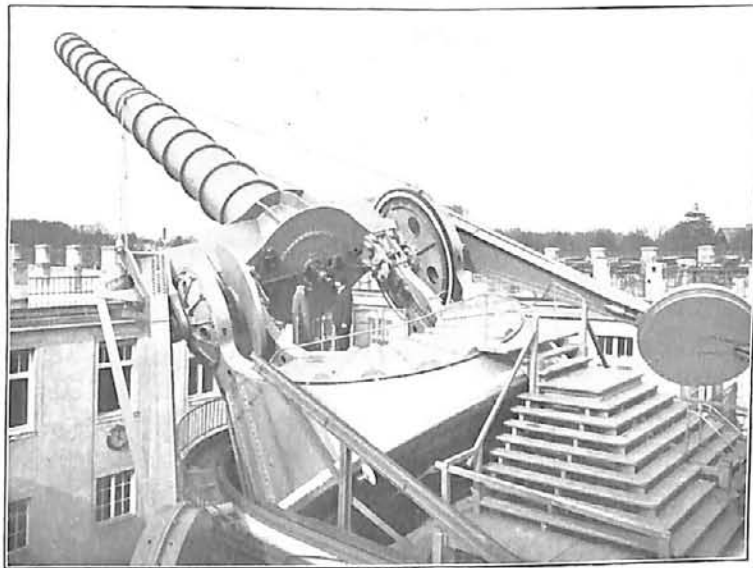
Das große Fernrohr (21 Meter Länge) der Treptow-Sternwarte mit dem Okularende, den beiden Gegengewichten (220 Ctr.) und der südlichen Zugangstreppe.
