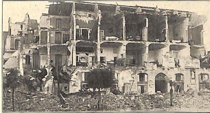
Abb. 2. Zerstörtes Wohnhaus in Messina (1908).
